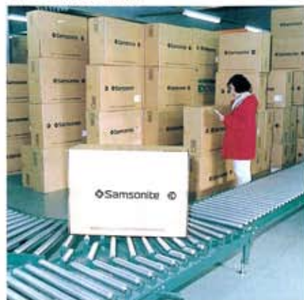
合流・分岐にローラ方向転換機
